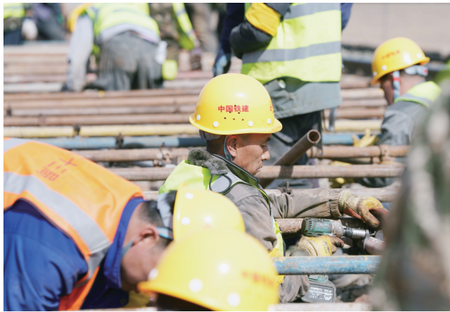
4月14日,工人在佳同铁路扩能改造工程富锦站改造现场施工。
