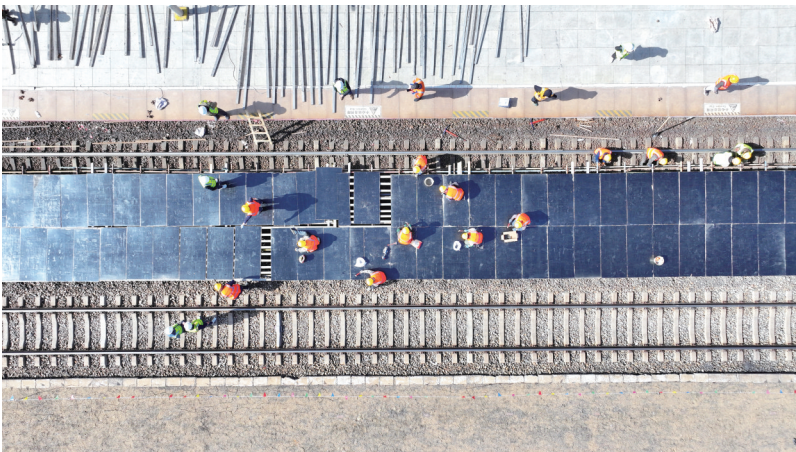
4月14日,佳同铁路扩能改造工程富锦站内施工人员进行临时站台搭建施工作业(无人机照片)。
