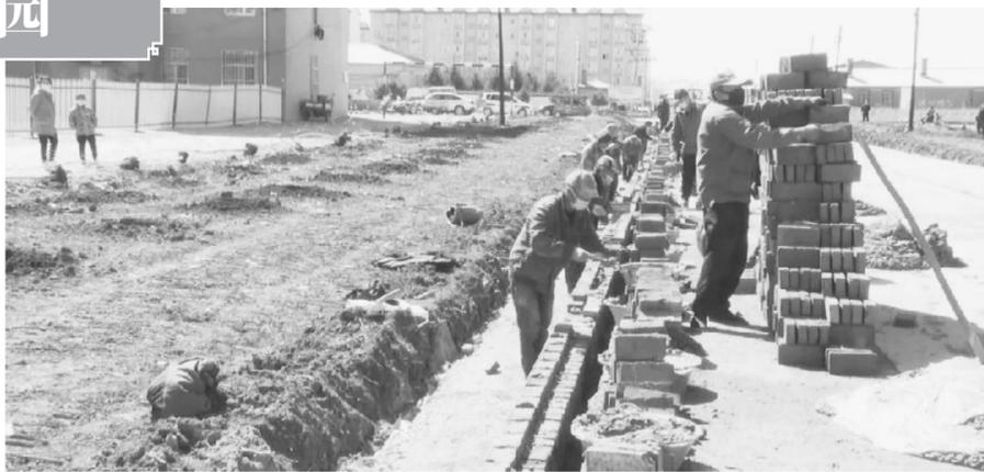
近日，笔者在望奎县望奎镇厢红五村村屯绿化现场看到，村民们三五成群，有的栽植树苗，有的修建排水渠，有的安装路灯，大家都干得热火朝天。据了解，厢红五村本次村屯绿化共栽植树苗1000余棵、新修排水渠1000延长米、安装路灯150余盏、修建入户桥涵100余个。图为村民在铺设路边沟。
