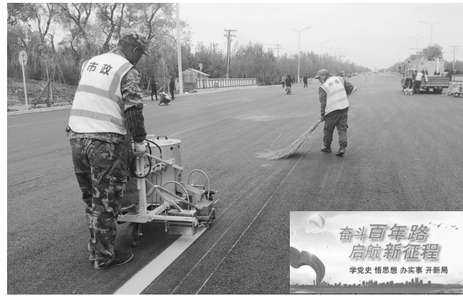
市政工人在施划交通标志标线。 全媒体记者 孙曙光 摄
